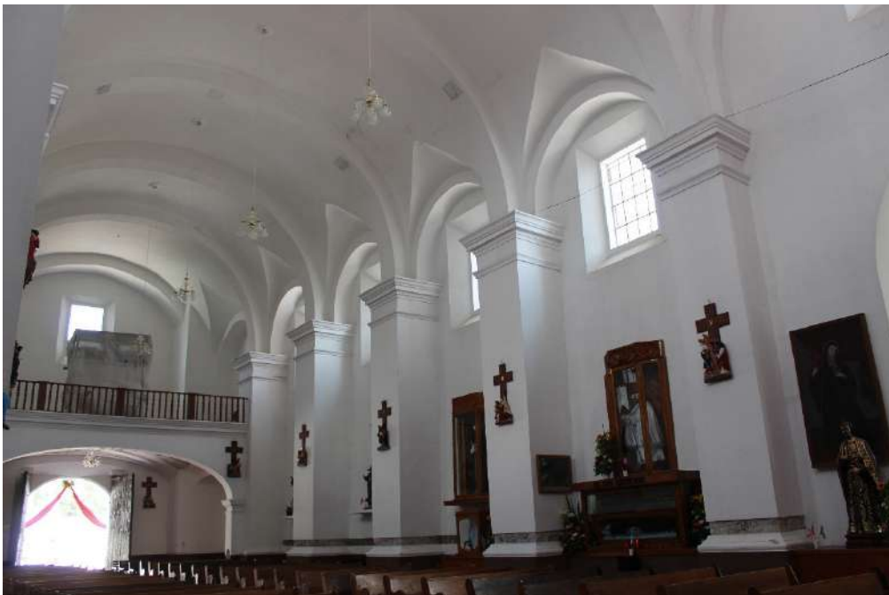
Imagen 2.2. Contrafuertes internos de la iglesia conventual de Amozoc. Fuente: Acervo fotográfico de Pedro Ayala Soledad, Amozoc, Pue., a 02 de julio de 2022.
