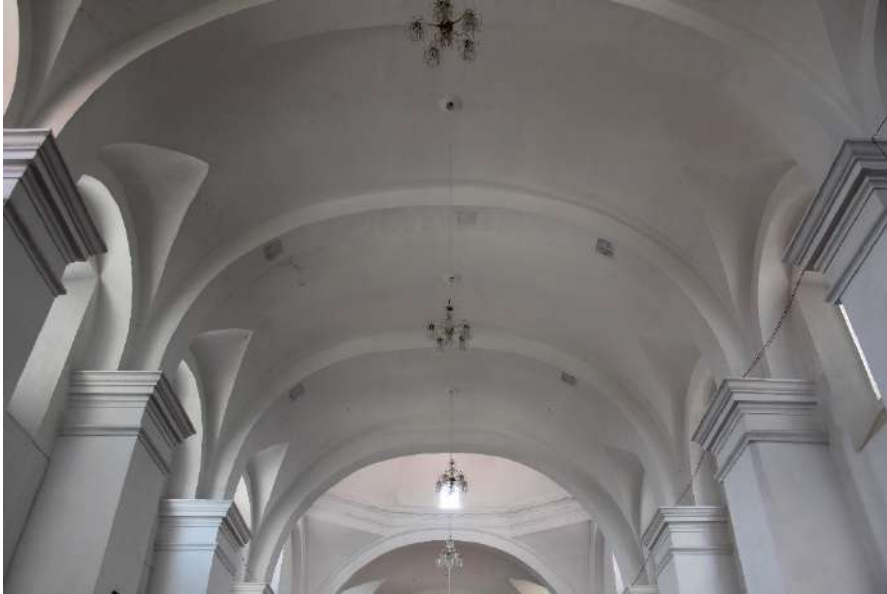
Imagen 2.1. Bóveda de cañón corrido con lunetos de la iglesia conventual de Amozoc. Fuente: Acervo fotográfico de Pedro Ayala Soledad, Amozoc, Pue., a 02 de julio de 2022.
